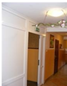
Wyjście ewakuacyjne na piętrze
